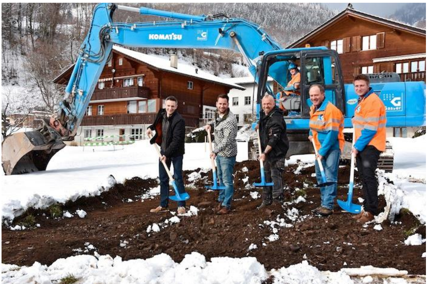
Es gab dann doch noch ein offizielles Spatenstichfoto. (vlnr) Andreas Wegmüller (Architekt), Marc. A. Trauffer, Gölä, von der Firma Gasser Erwin Rufibach (Baggerführer), Hansueli Marmet und Ambros Gasser.
