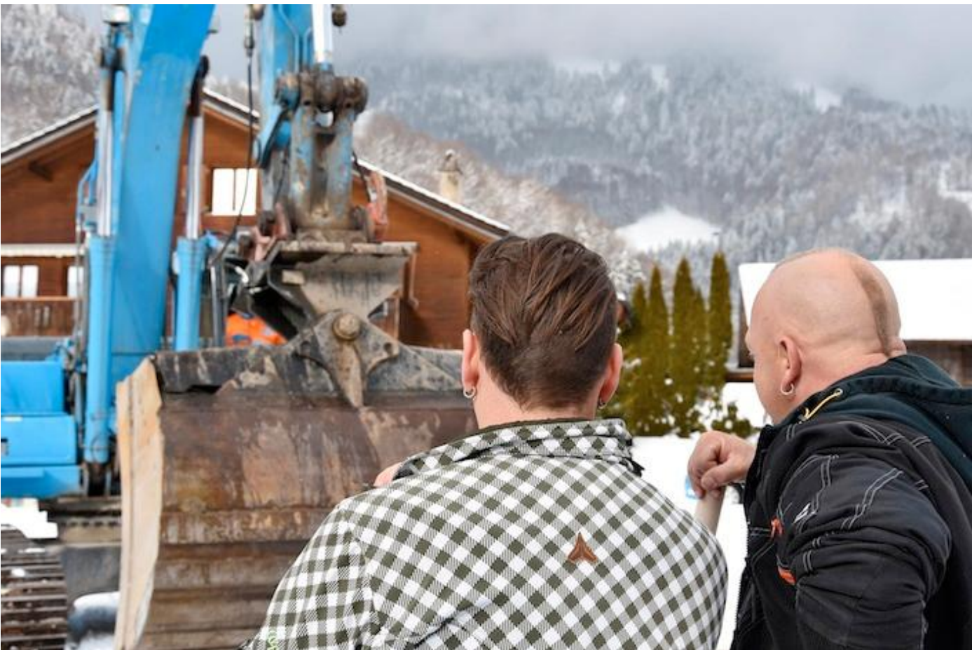
Besser dem Bagger bei der Arbeit zusehen, wenn der Zeitplan eingehalten werden soll.
